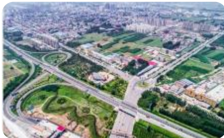
雄安新区管廊建设项目
